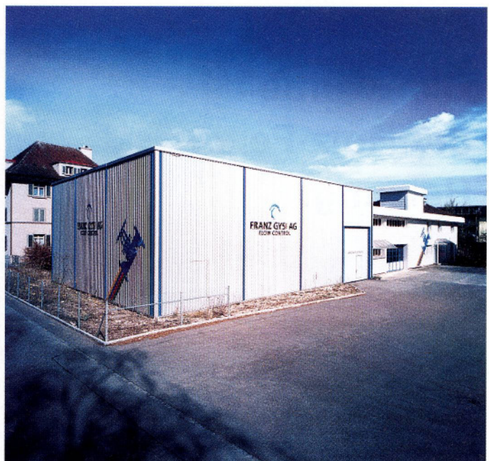
Die Franz Gysi AG im aargauischen Suhr. Links der Anbau mit dem neuen Ausbildungslabor.
